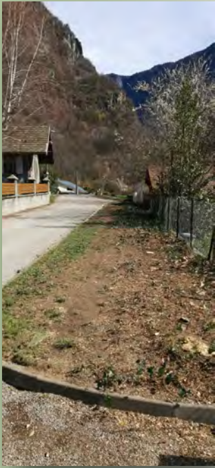
Suppression d'une haie de cyprès rue des Michalets, fin mars.
