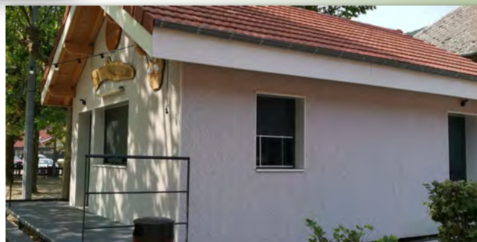
Suite à l'incendie de la troc box le 28 décembre 2022, la façade du local La Belle Lauze avait été touchée. L'approvisionnement des matériaux nécessaires à sa réfection étant très compliqué à obtenir, celle-ci n'a eu lieu qu'en juillet. La voici enfin restaurée ! Une place de parking supplémentaire sera créée en lieu et place du platane brûlé.
