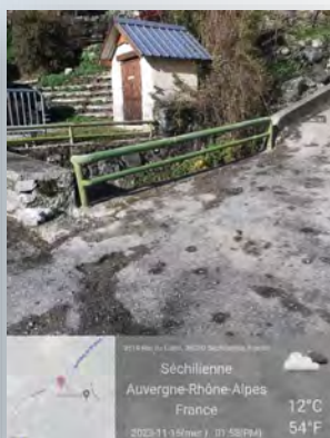
Réfection barrière pont des Blancs (Métropole)
