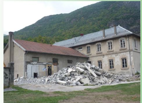
Le chantier a débuté au mois d'août dernier par le désamiantage du vide-sanitaire et du grenier puis par le démontage des préfabriqués utilisés par les classes maternelles et la démolition de la salle des fêtes. La structure du bâtiment école a été conservée tandis que l'ensemble des murs et des planchers ont été démolis.
